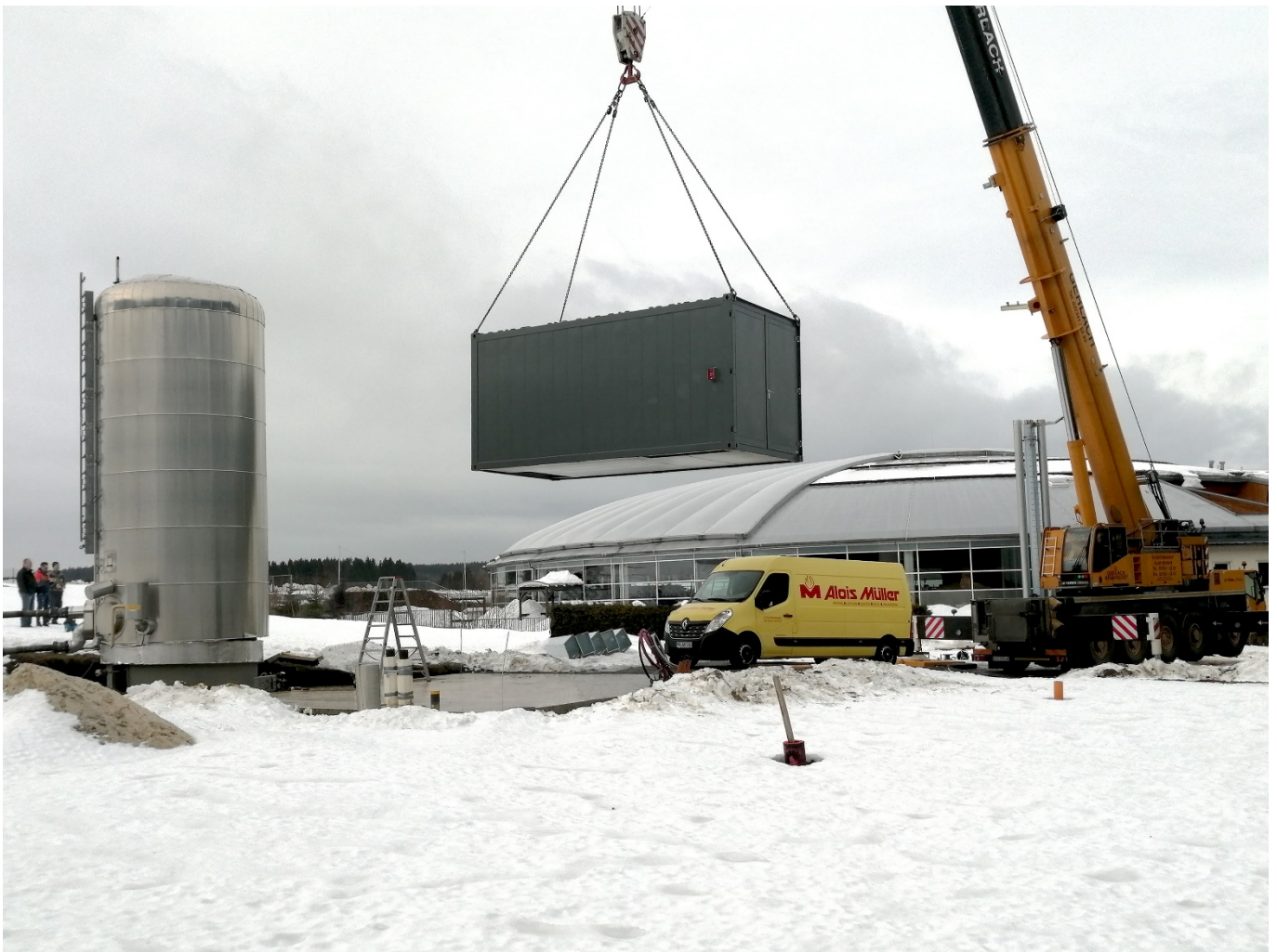
Anlieferung der BHKW-Container am Freizeitbad An der Silberstraße. Foto: Matthias Förster
